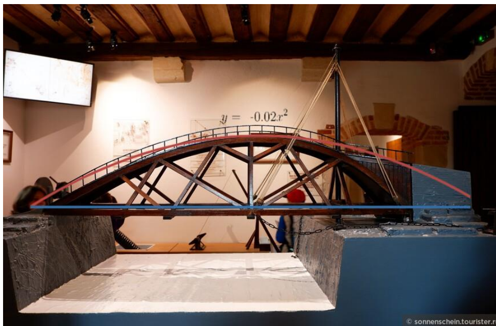
Рисунок 9 - Аппроксимация поверхности моста параболой
